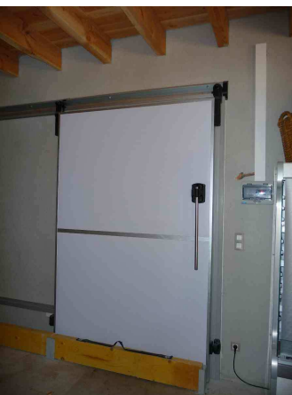
Nouvelle chambre froide sur isolée
